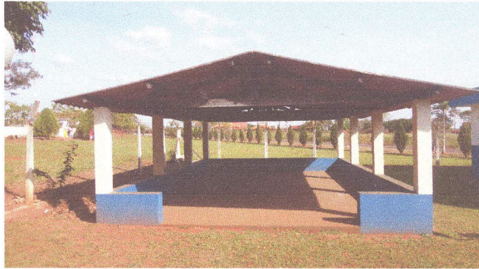
Foto 04: Cobertura Existente na Lateral Esquerda do Velório Municipal.
