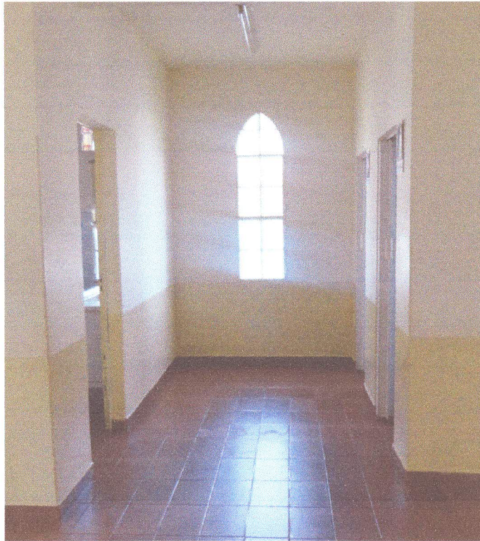
Foto 13: Corredor Velório Municipal.
