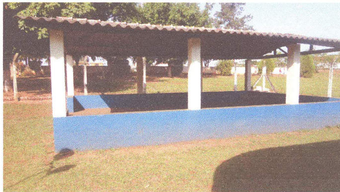
Foto 05: Vista Lateral da Cobertura Existente na Lateral Esquerda do Velório Municipal.
