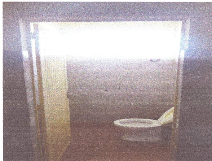
Foto 09: Banheiro Feminino Existente no Interior do Velório Municipal.
