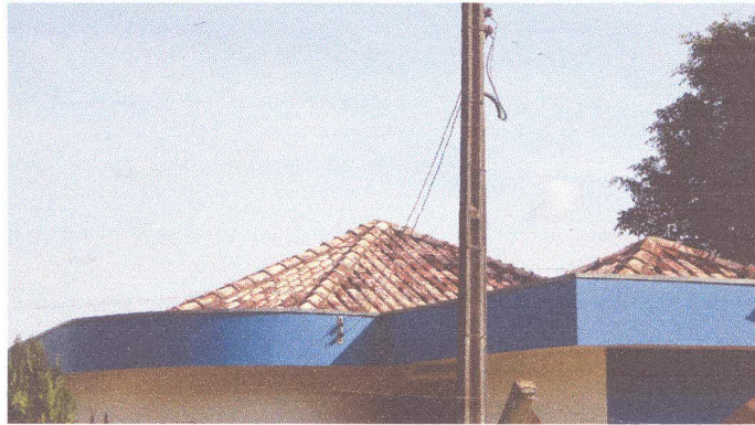
Foto 07: Vista do Telhado do Velório Municipal.
