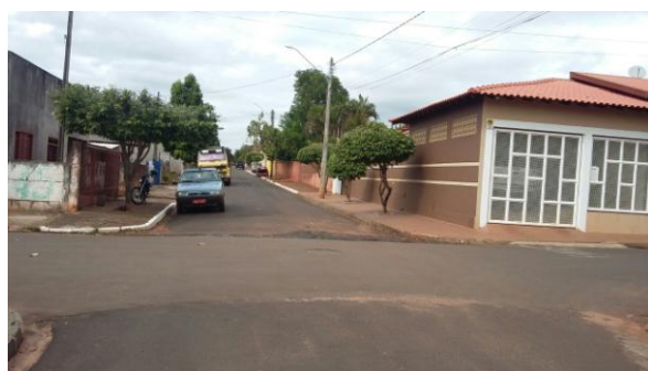
Foto 6.20 – Rua Treze de Maio – Sentido entrada da cidade
