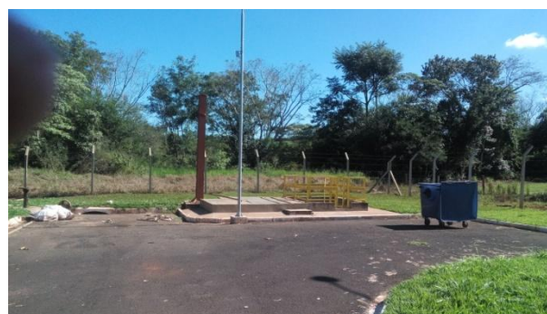
Foto 6.11 – Poço de sucção – EEE Final
