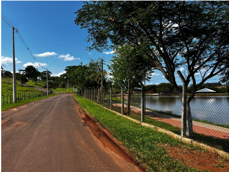
Alambrado, calçada com guia e sarjeta para segurança do munícipes
