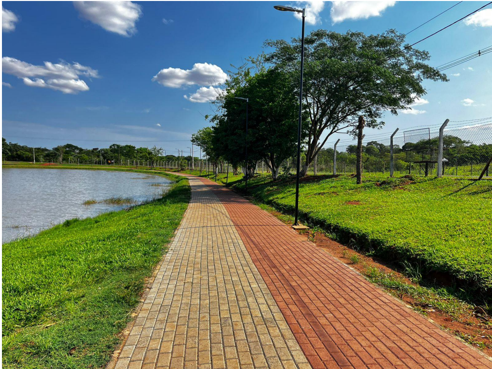
Instalação de palmeiras entre os postes de iluminação
