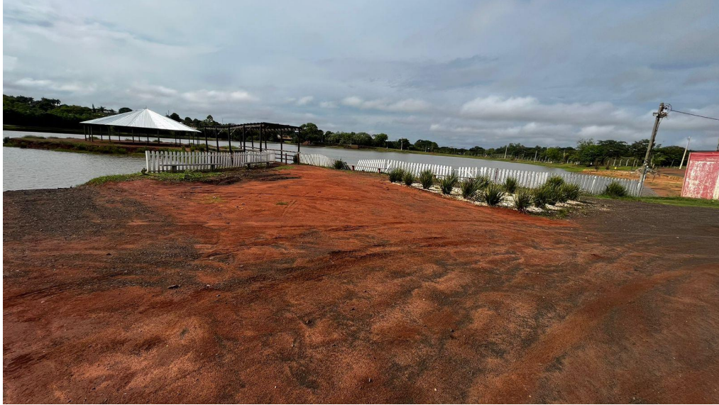
Instalação de guarda corpo em aço galvanizado pintado para segurança
