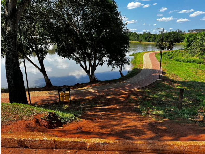
Instalação de escada para melhor acesso
